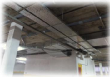
(1) ALTURA E INFRAEST..
